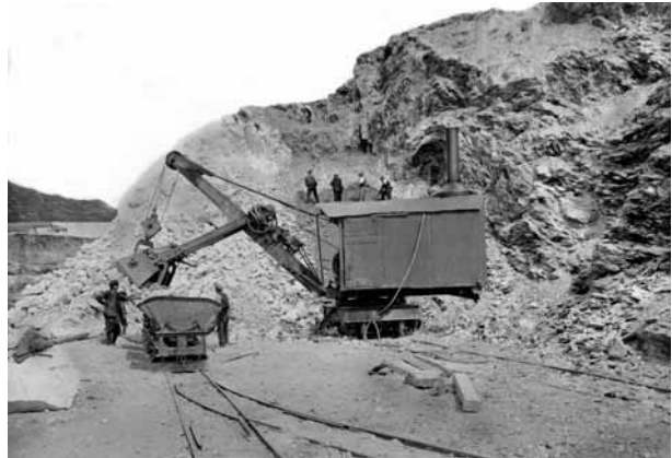
Photo 3. La première pelle à vapeur sur rails, baptisée « La fumeuse », en activité à partir de 1920 (cliché SATL, ouvrage du centenaire, p. 64).
