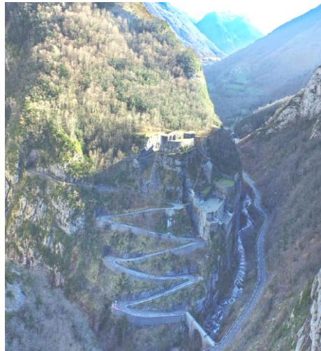
ENJEUX = Fort, Pont d'Enfer, RN134, passerelle, usagers humains (ouvrages et personnes à protéger)
