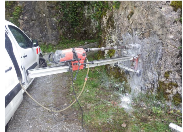
Carottage horizontal d'un affleurement rocheux situé dans le 1 er lacet du Fort pour prélever un échantillon intact à analyser en laboratoire – Avril 2018
